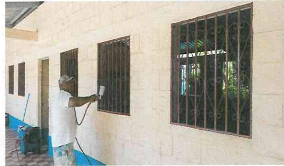
Foto 8: Mantenimiento de 15 balcones (Limpieza, reparación y pintura).
