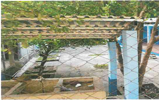
Foto 9: Cambio de techo y estructura metálica en pila.
