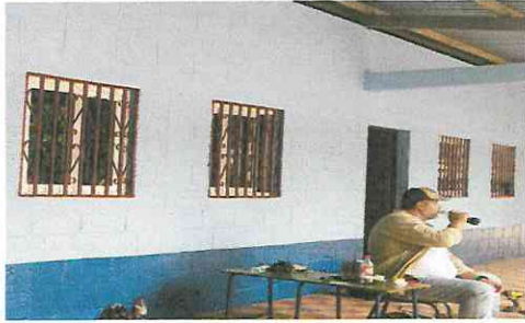
Foto 7: Sustitución de ventanas por tipo pvc.
