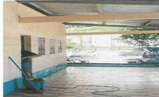
Foto 10: Colocación de piso cerámico en aula.
