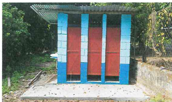
Foto 3: Cambio de tubería del tanque a baños .
