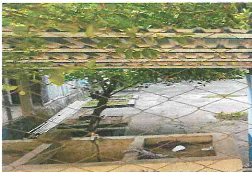
Foto 11: Colocación de azulejo en pila existente.
