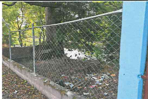
Foto 1: Mantenimiento de tramos de circulación de malla con tubo y hierro de media
