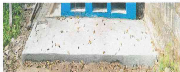
Foto 6: Reparación de banqueta de baños.
