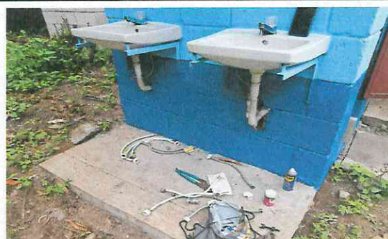
Foto 2: Mantenimiento de tres baños y dos lavamanos
